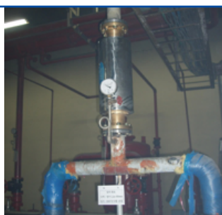
Después de la instalación
