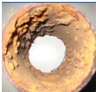
Antes de la instalación (Agosto 18, 2007)
