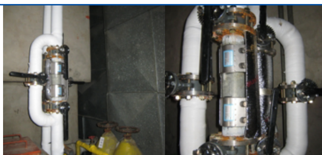
Instalación en punto de inspección
