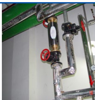
Después de la instalación
